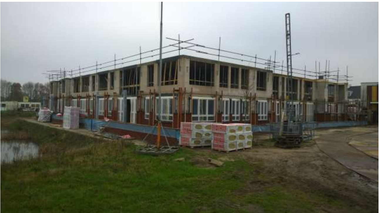
Eerste slag van eht gevelmetselwerk is klaar
