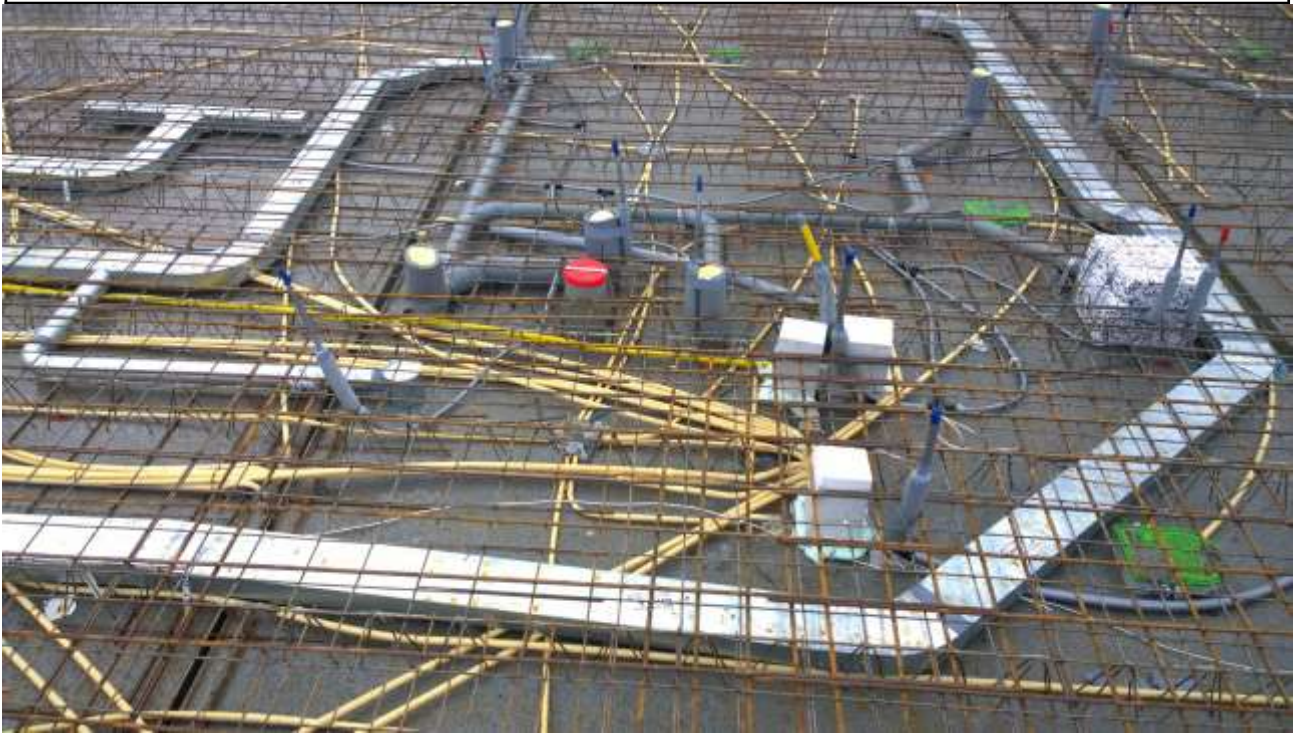
Web van leidingen in de betonvloer
