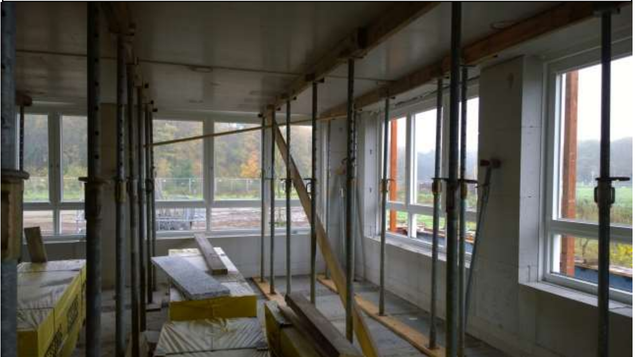
Stempels onder de zojuist gestorte betonvloer
