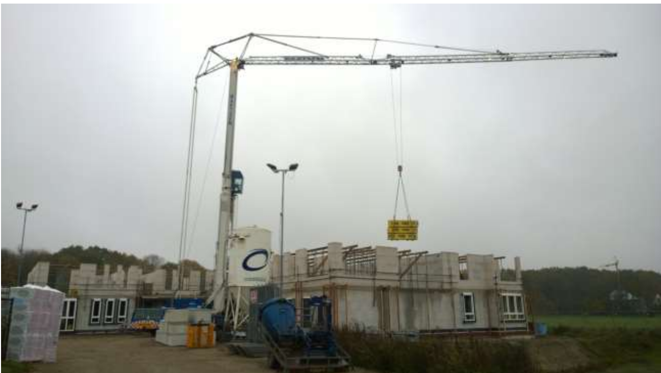
Een pak binnenwandpanelen wordt op de betonvloer gehesen
